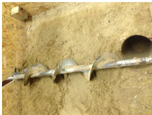
Рис. 1. Разработка грунта в направляющую скважину
