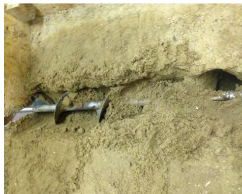
Рис. 1. Разработка грунта в направляющую скважину
